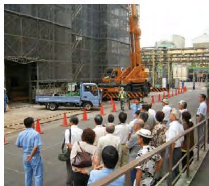
脱臭設備見学会
