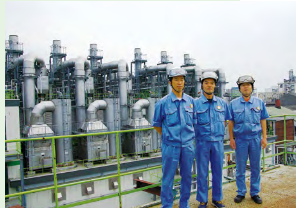
川崎工場の心臓部、自家発電機の制御を担当する原動課の担当者。6基のボイラーの前で
