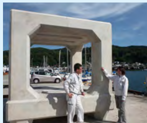
静岡・伊東港の沖約1キロ、水深8メートルの海底に設置された環境活性コンクリート製の魚礁(重量21.8トン)。日建工学(株)担当者(左)と、味の素(株)担当者(右)。
