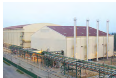
約1カ月分、1万トンのもみ殻が貯蔵できる巨大なサイロ(写真奥)とボイラー(手前)
